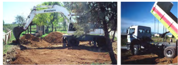
Begoña Pérez Rivera, Del cambio de color al intercambio de tierras , 2002. Proceso de ejecución de la obra.
