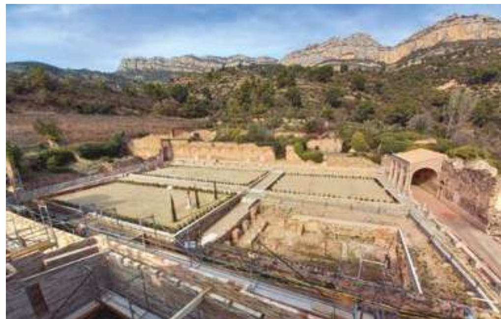
Fig. 8. Vista del claustre al final de l'obra. En primer terme, el quarteró que mostra l'excavació arqueològica. (Imatge: Josep M. Vila)
