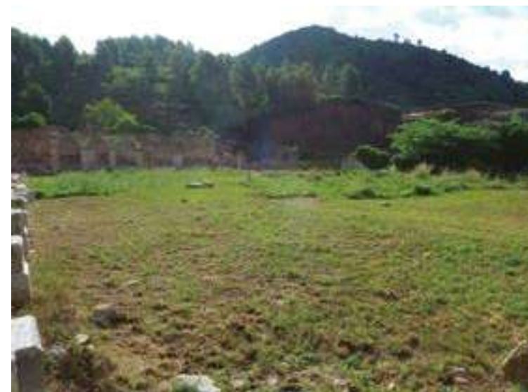
Fig. 2. Vista general del claustre major abans de la intervenció. (Imatge: Josep M. Vila.)
